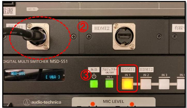
HDMIケーブルをPCなどの映像出力装置に接続します。
